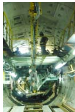
▲ (圖三) 參觀大安森林公園站施工—潛盾隧道工程
